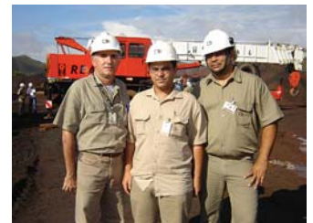
Transportador de Correia 24 polegadas pronto para ser instalado na ITMS (à esquerda).
