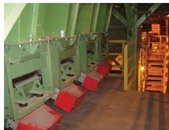
À esquerda: novo sistema de silos, fabricado e montado pela Nunes, aguarda interligação com o sistema atual. Interligação se dará na parada de quatro dias da aciaria, a ser realizada no final de novembro.
